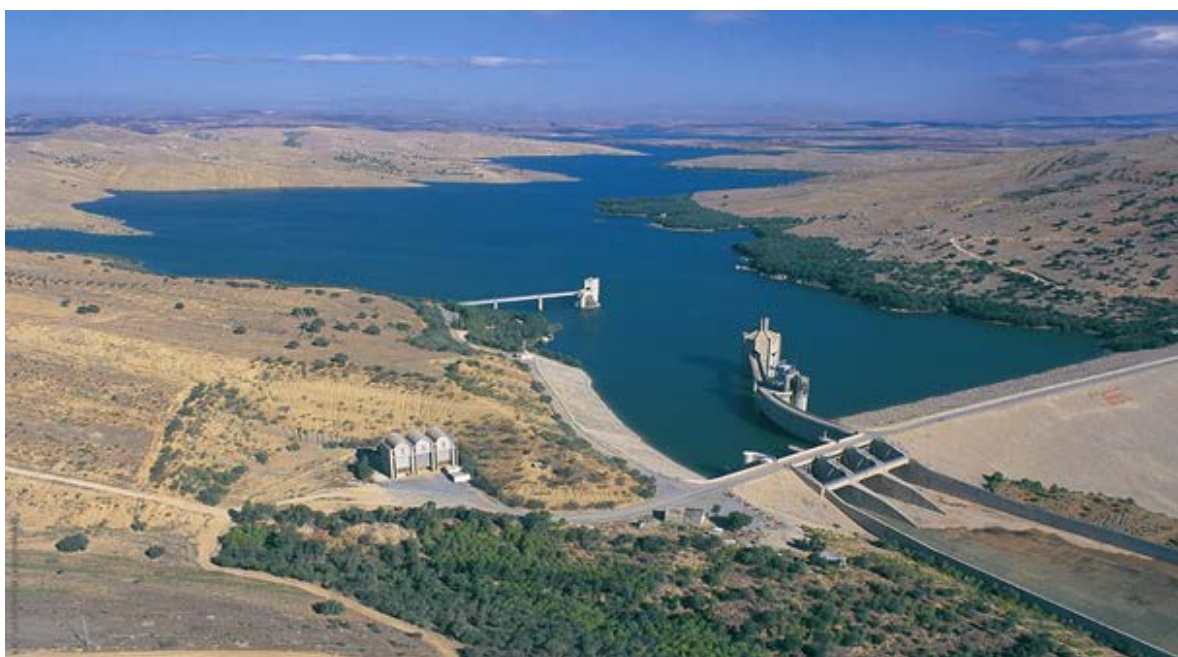
Barrage Sidi Salem
